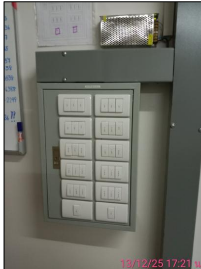
รูปภาพที่ 2.15 สวิตช์ควบคุมอุปกรณ์ไฟฟ้าแสงสว่าง
