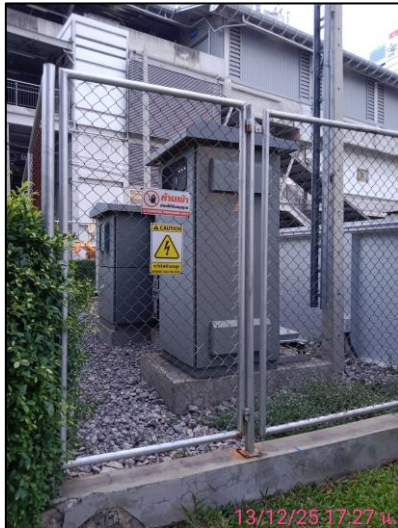
รูปภาพที่ 2.9 หม้อแปลงไฟฟ้า
