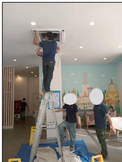
รูปภาพที่ 2.33 การล้างทำความสะอาดเครื่องปรับอากาศ
