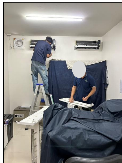
รูปภาพที่ 2.33 การล้างทำความสะอาดเครื่องปรับอากาศ
